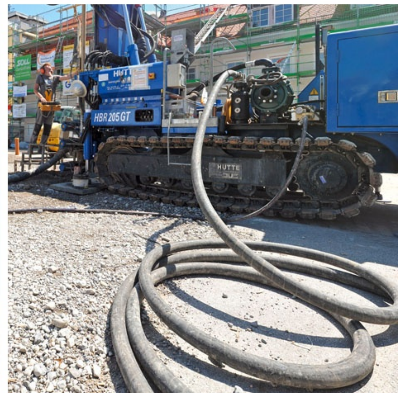
Geothermie Oberflächenbohrung Rathaus Penzberg, Geowell.
