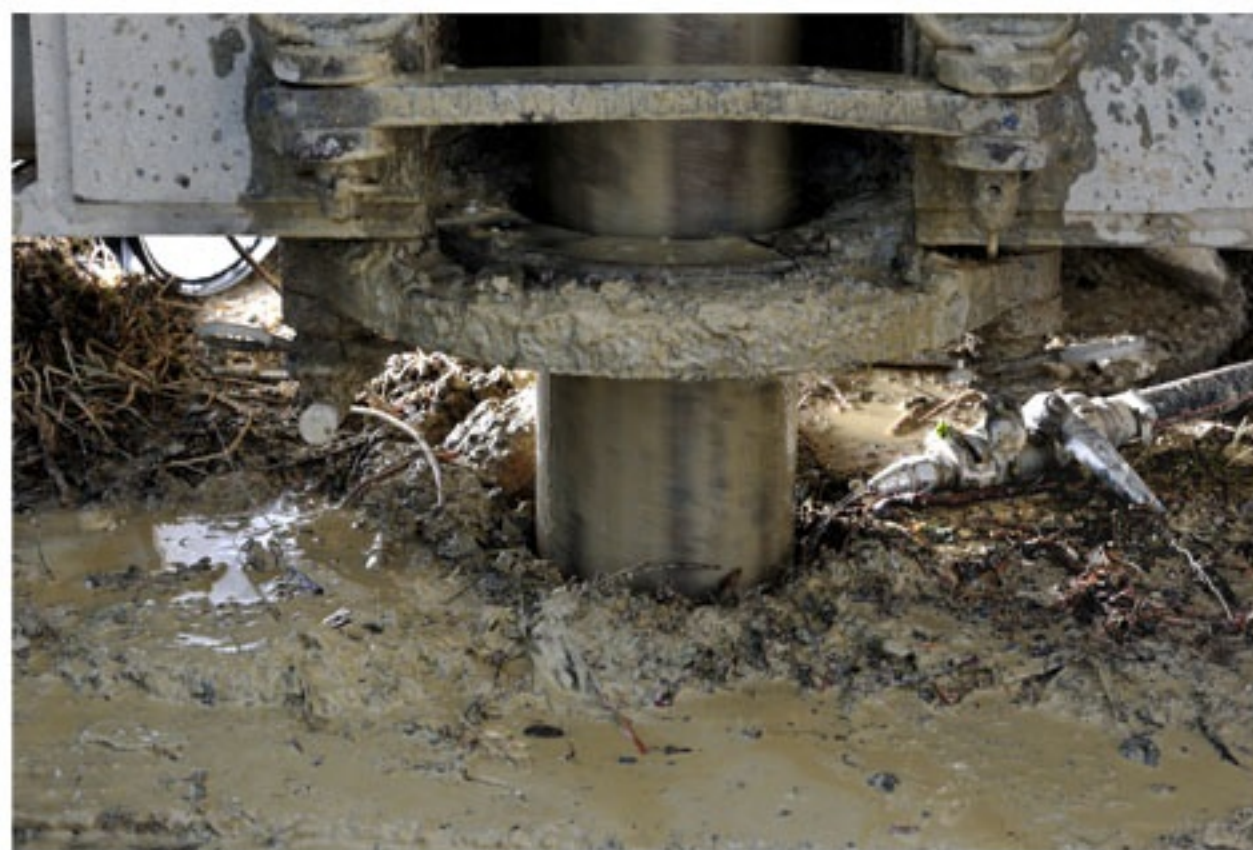
Geothermie Oberflächenbohrung für Wohnhaus Regensburg, Geowell.
