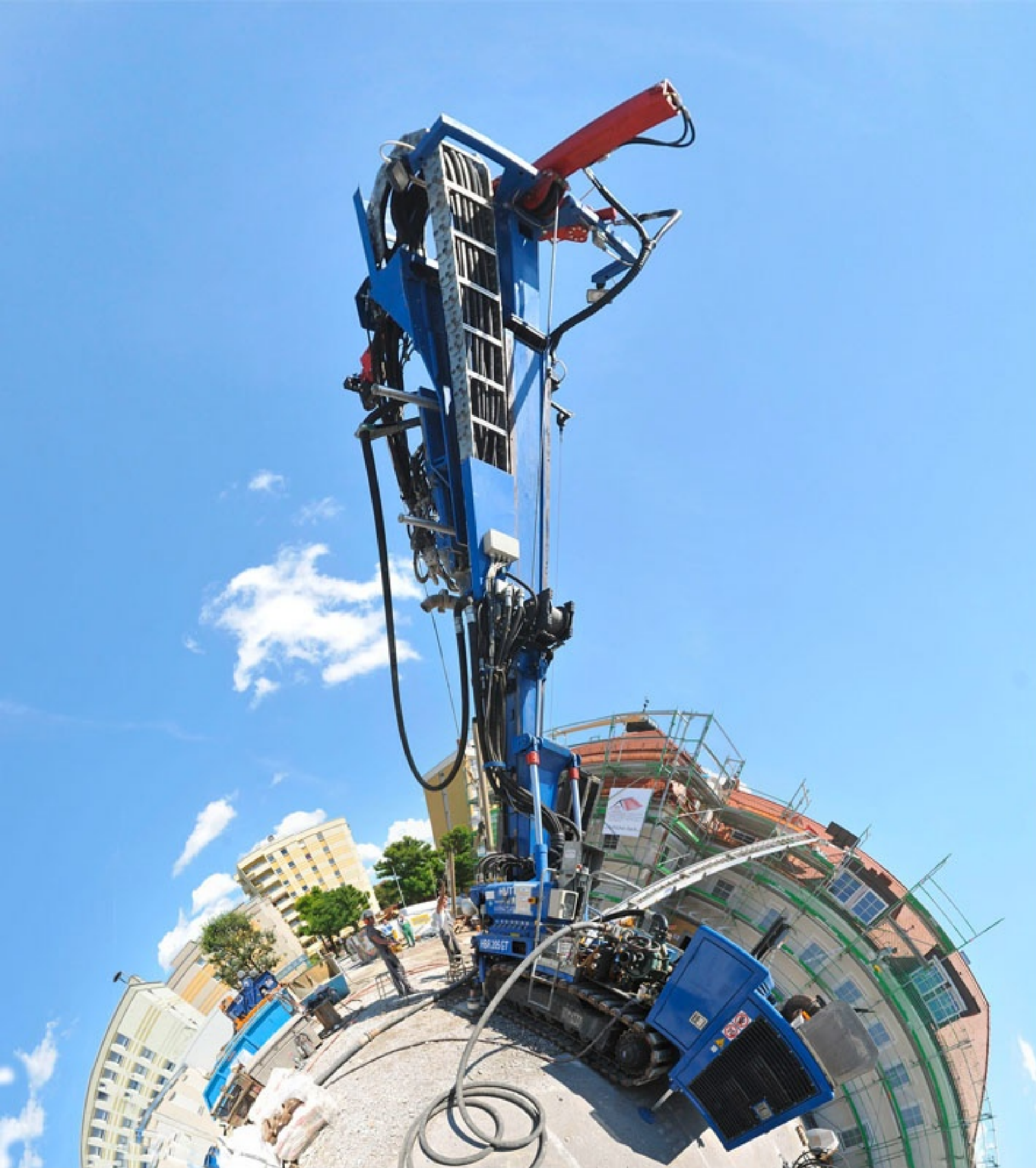
Geothermie Oberflächenbohrung Rathaus Penzberg, Geowell.
